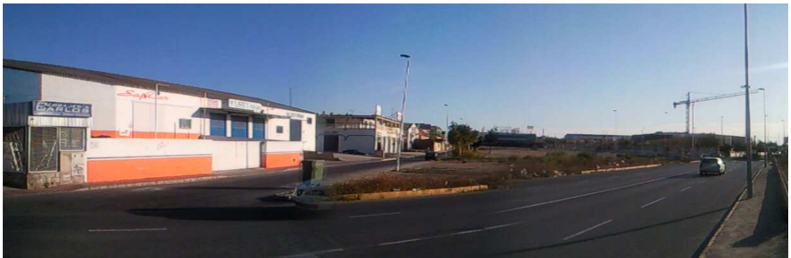
Ilustración 9 Vista desde el Norte de la actuación. Fondo escénico exclusivamente urbano.
