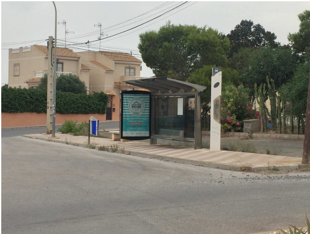
Marquesina 2. Calle Carreño con Las Arenas.
