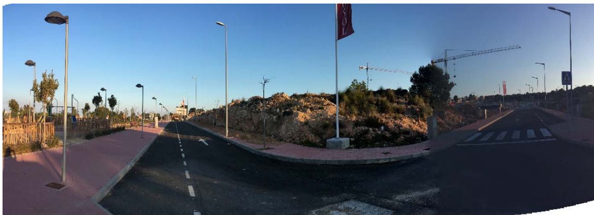
Vista desde el cruce de la calle I y calle B. Foro escénico urbano.
