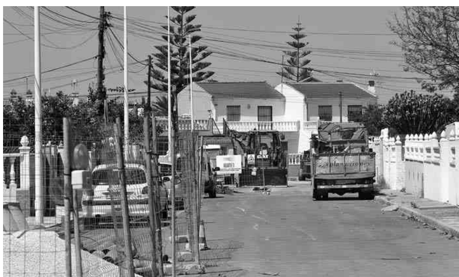
Obras en la Torreta Florida.
