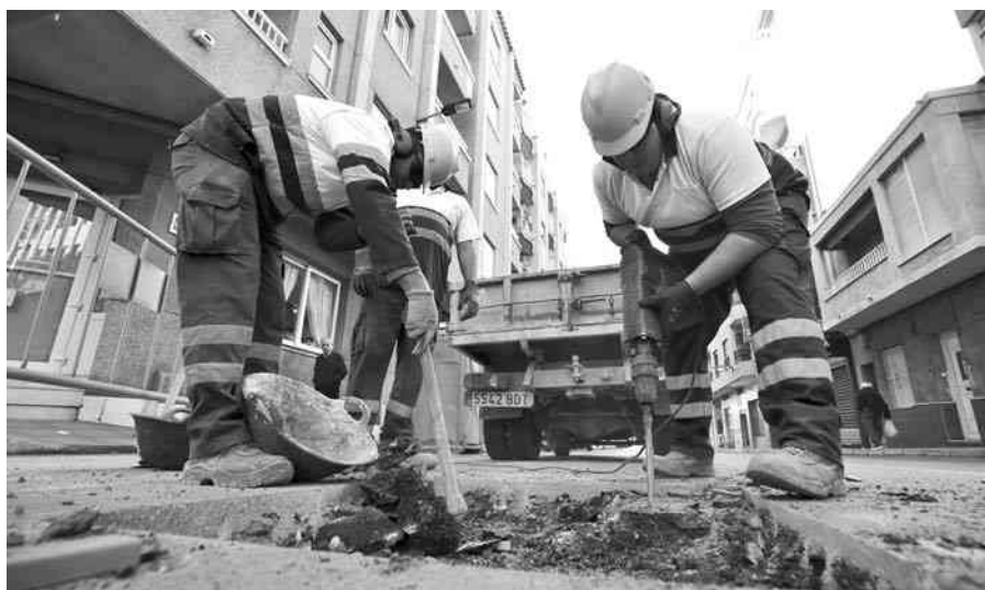
Obras de saneamiento en la calle Antonio Machado.
