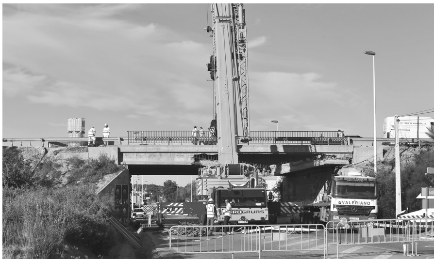
Momento de los trabajos de reparación del puente de la N-332.
