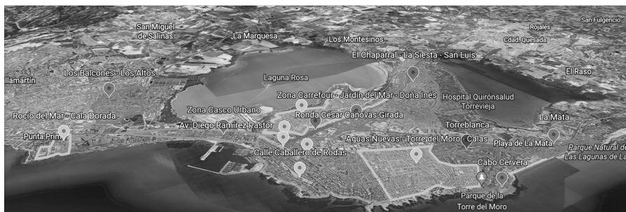
Vista general de zonas donde se llevará a cabo el plan de asfaltado.
