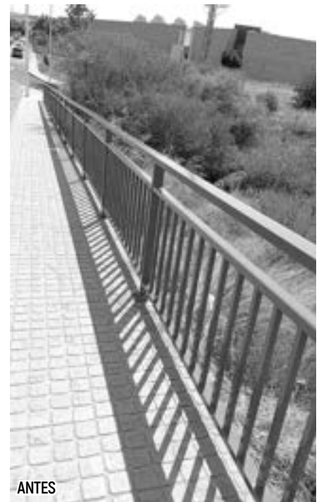
Fotos del antes y después de los trabajos de pintado y conservación de la barandilla y de las protecciones de hormigón.
