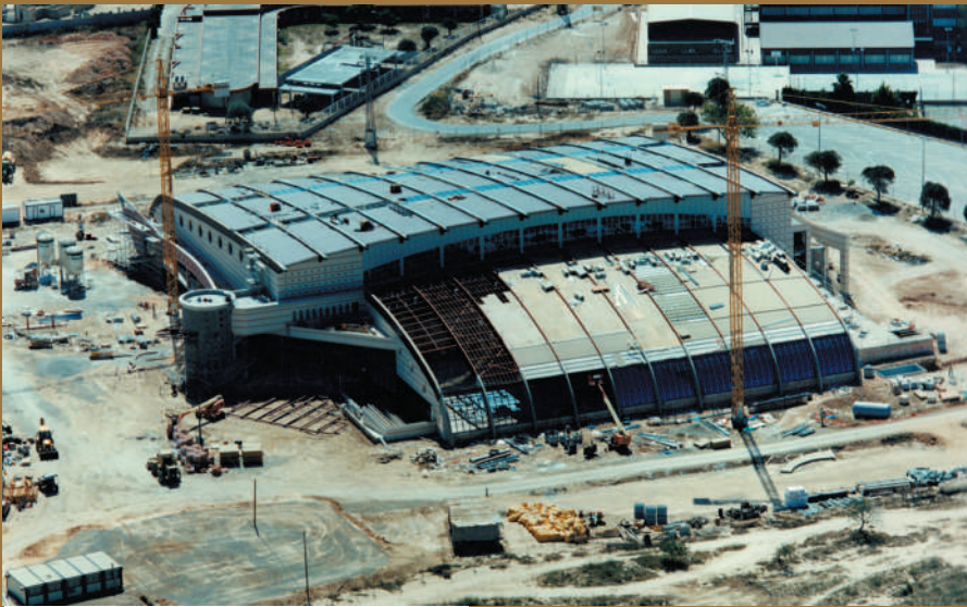
OBRA DEL PALACIO 1999.
