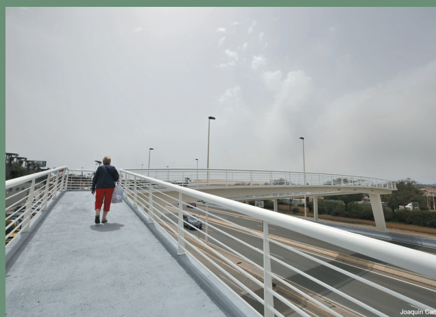
Así luce la pasarela de la CV-905 después de las tareas de mantenimiento en la reparación de daños en barandillas y elementos de protección de pilares.
