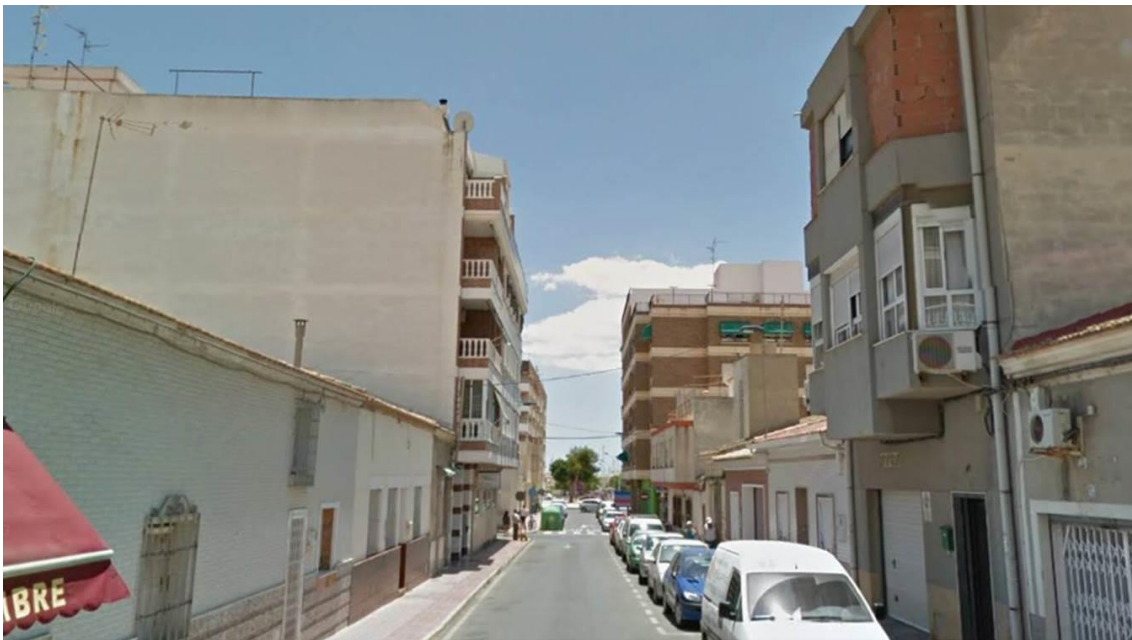
Fotografía 4. Vista desde la Calle San Julián
