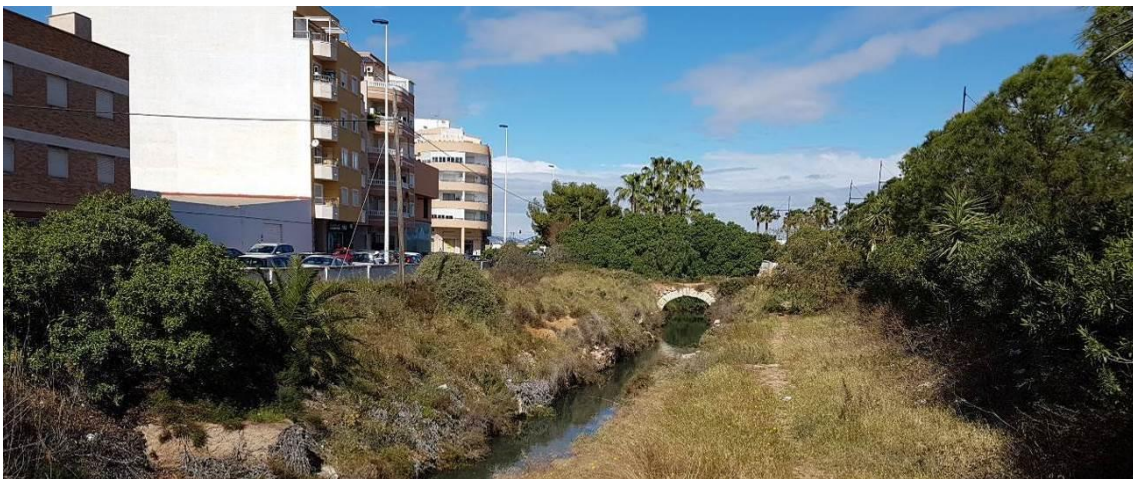
Fotografía 18. Vista hacia el norte desde la Av. Dr. Gregorio Marañón
