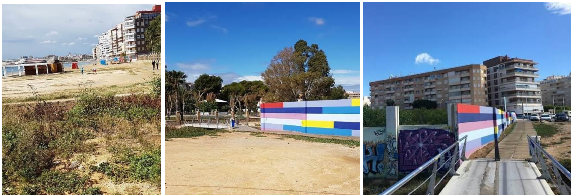
Fotografías 7, 8 y 9. Vista desde la desembocadura del acequión y de la pasarela en el extremo sur de la Parcela (Continuación Calle Salero)
