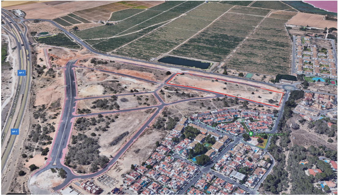
Vista del ámbito desde el Sur
