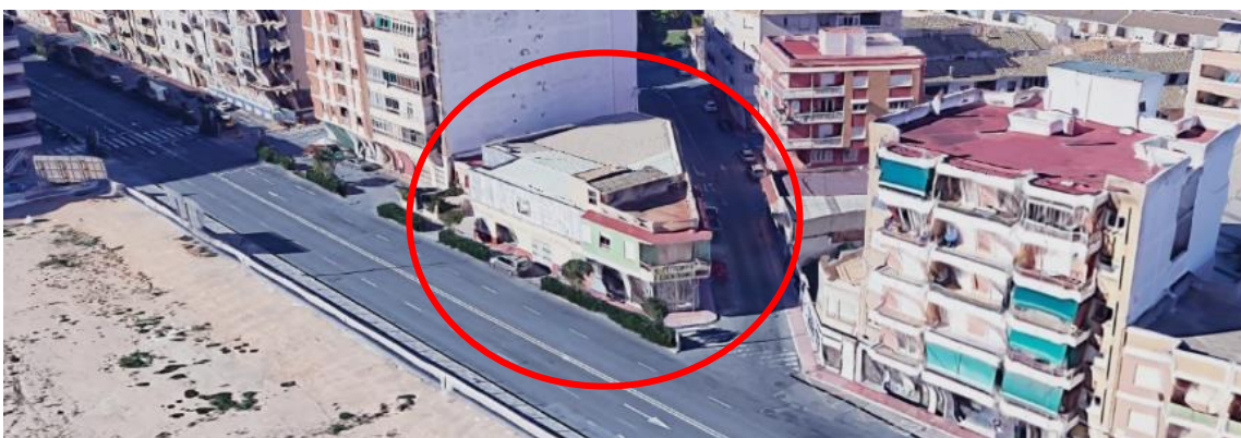
Detalle del inmueble cuyas alineaciones se reajustan con la MP nº 52 y se concretan en este Estudio de Detalle.
