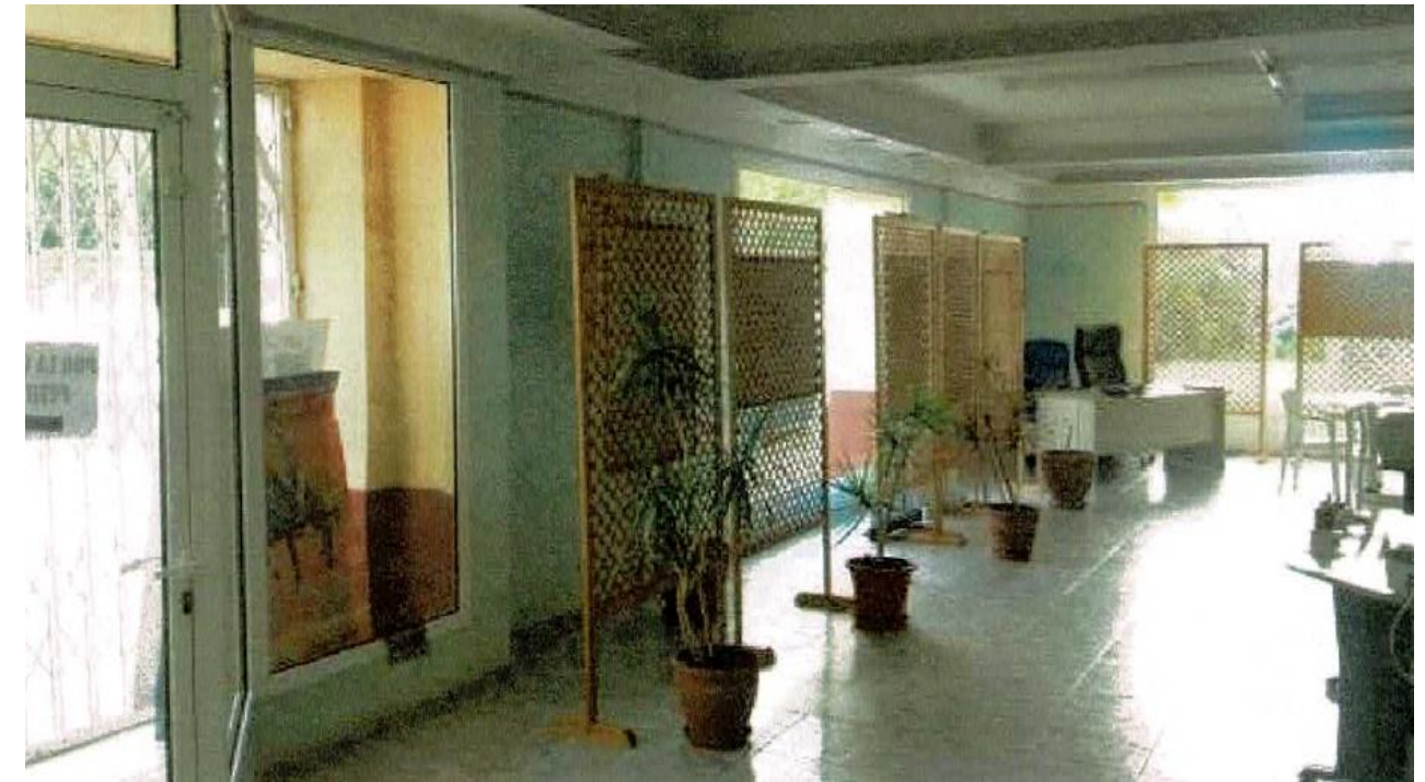
Imagen 2. Estado interior Planta baja 34
