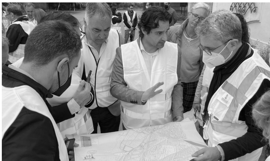
El alcalde de Torrevieja, Eduardo Dolón, y el conseller de Política Territorial, Obras Públicas y Movilidad, Arcadi España, visitaron las obras del puerto.
