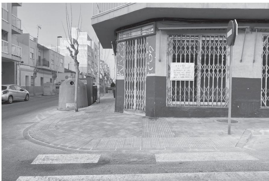
Ejemplo de accesibilidad ya ejecutado en una calle de Torrevieja.
