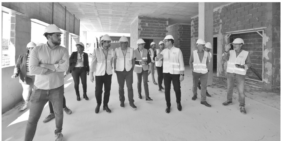
Después se trasladaron a las obras del colegio Amanecer para comprobar in situ el avance de los trabajos.
