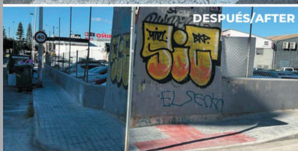
La actuación en la calle Gabriela Mistral, que abarcó unos 240 metros lineales de acera, ha incluido la retirada de bordillo en mal estado y colocación de nuevo bordillo de hormigón; la ejecución de nueva solera de hormigón sobre la existente; y la dotación de accesibilidad.
